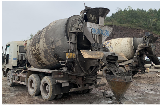
地面大流量钻孔注浆
