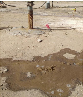
地面钻孔注浆
