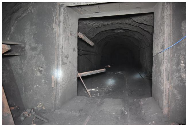
图2 第二道风门仅余二根金属骨架
