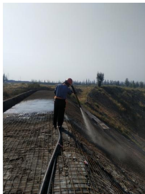
边坡挂网喷浆堵漏风
