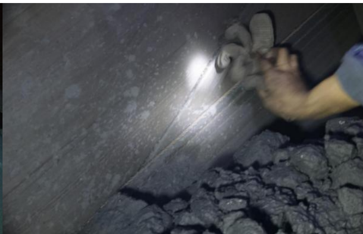
事故前钢丝绳裸露情况
