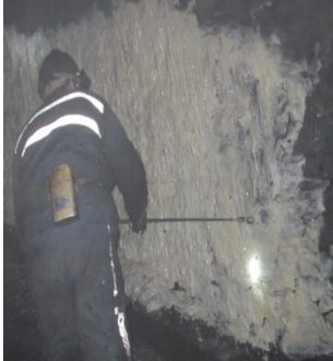
煤壁喷涂堵漏
