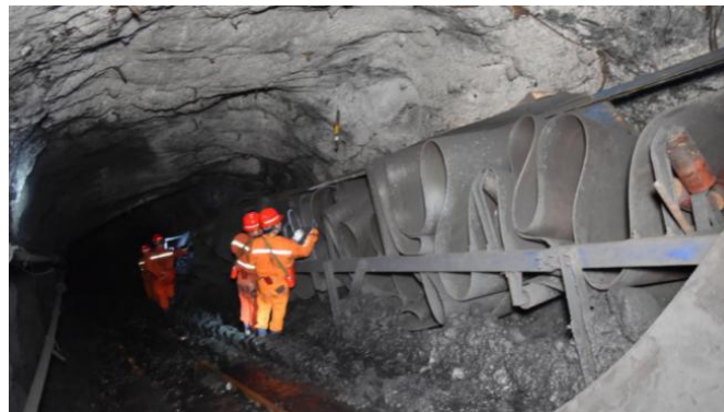
事故后上皮带断落到下方情况
