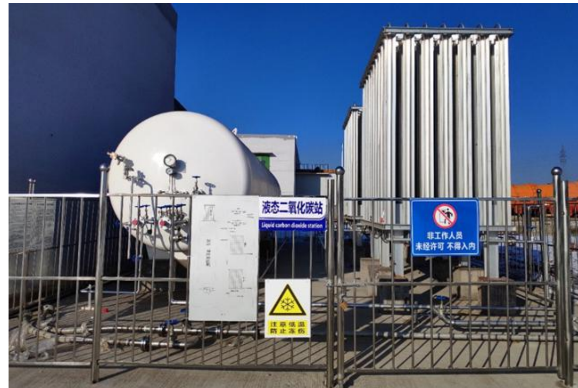
红柳林煤矿建设实物图
