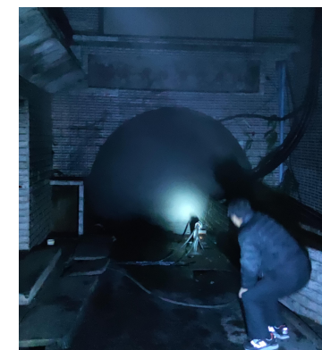
副井井口上方冒烟情况勘察
